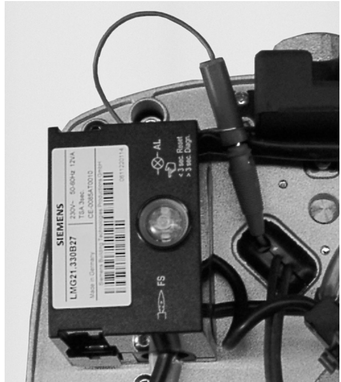
Abb. 20: Der Anschluss der Ionisationselektrode ist steckbar ausgeführt.
